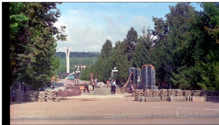
Идет строительство будущего архитектурно-мемориального комплекса / ФОТО ИЗ ФОНДОВ МУЗЕЯ НЕФТИ КОМПАНИИ
