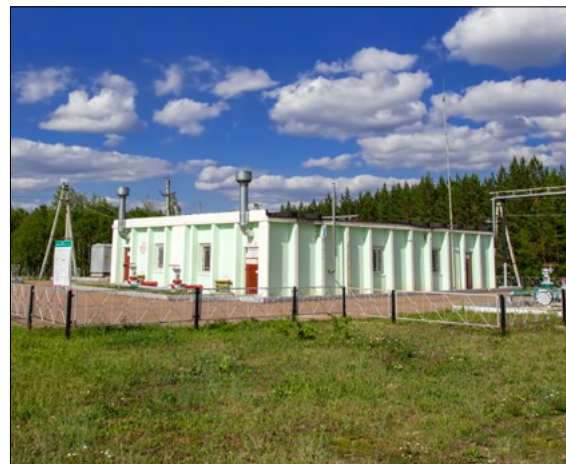
КНС-32 НГДУ «Лениногорскнефть» / ФОТО СЕРГЕЯ ТРУСОВА
